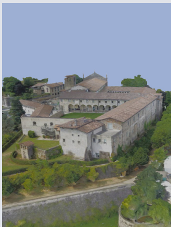
Progetto FARB dal titolo "Il rilievo, la conservazione e la valorizzazione delle 'Mura Veneziane' e dell'ex-convento di Sant'Agostino: documentazione 3D e analisi storico-costruttive".
